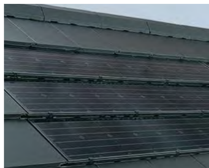
2 | dachintegrierte PV-Anlage
