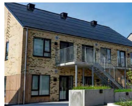
3 | dachintegrierte PV-Anlage
