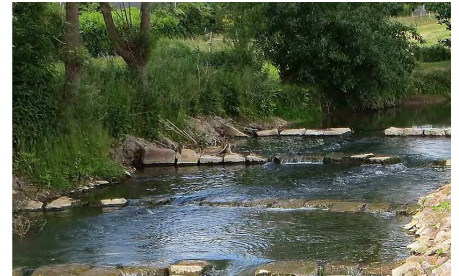
2 | Ökologischer Wasserbau - Sohlgleite
